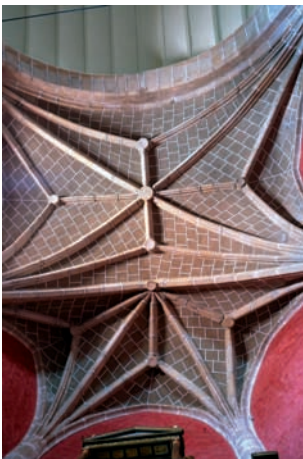
Bóveda del ábside
