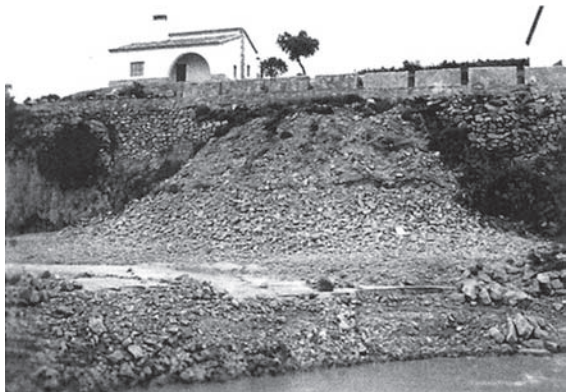
Casa del encargado de la central eléctrica
