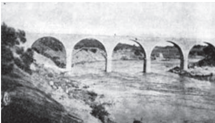
Puente de 1927 que se derrumbó
