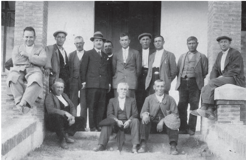
Miguel Alfonso Gómez (cuarto por la derecha, de pie y con gorra) con su cuadrilla de operarios en 1931, cuando finalizan de construir el Colegio de la Vía
