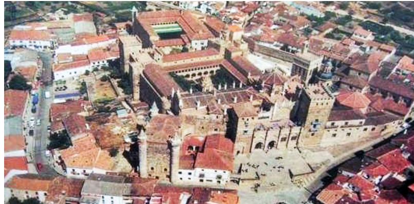
XII.- Vista aérea del complejo monástico. En primer término, a la izquierda, el solar donde se encontraba la Hospedería Real.
