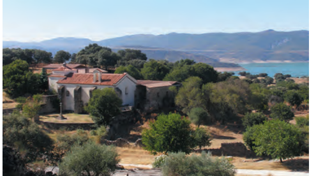
Imagen 1: Vista general del convento de San Francisco. Al Fondo, el Pantano de Valdecañas.
